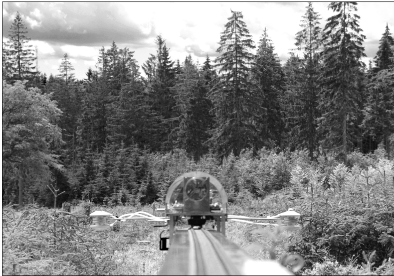
Restarbeiten vor der RW-Erweiterung
