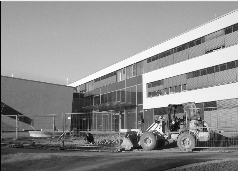
Restarbeiten vor der RW-Erweiterung
